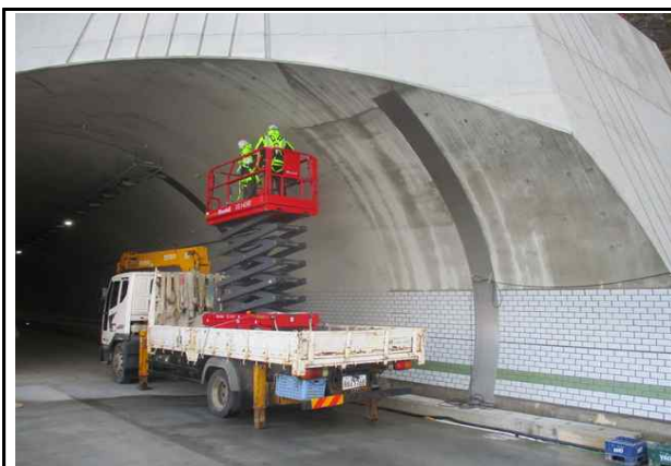
고소작업차를 이용한 외관조사
