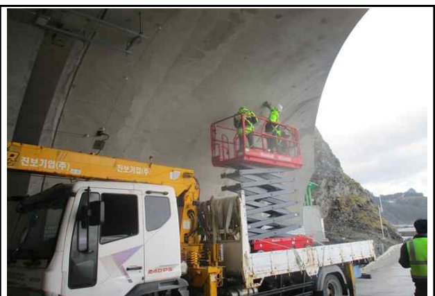
고소작업차를 이용한 외관조사
